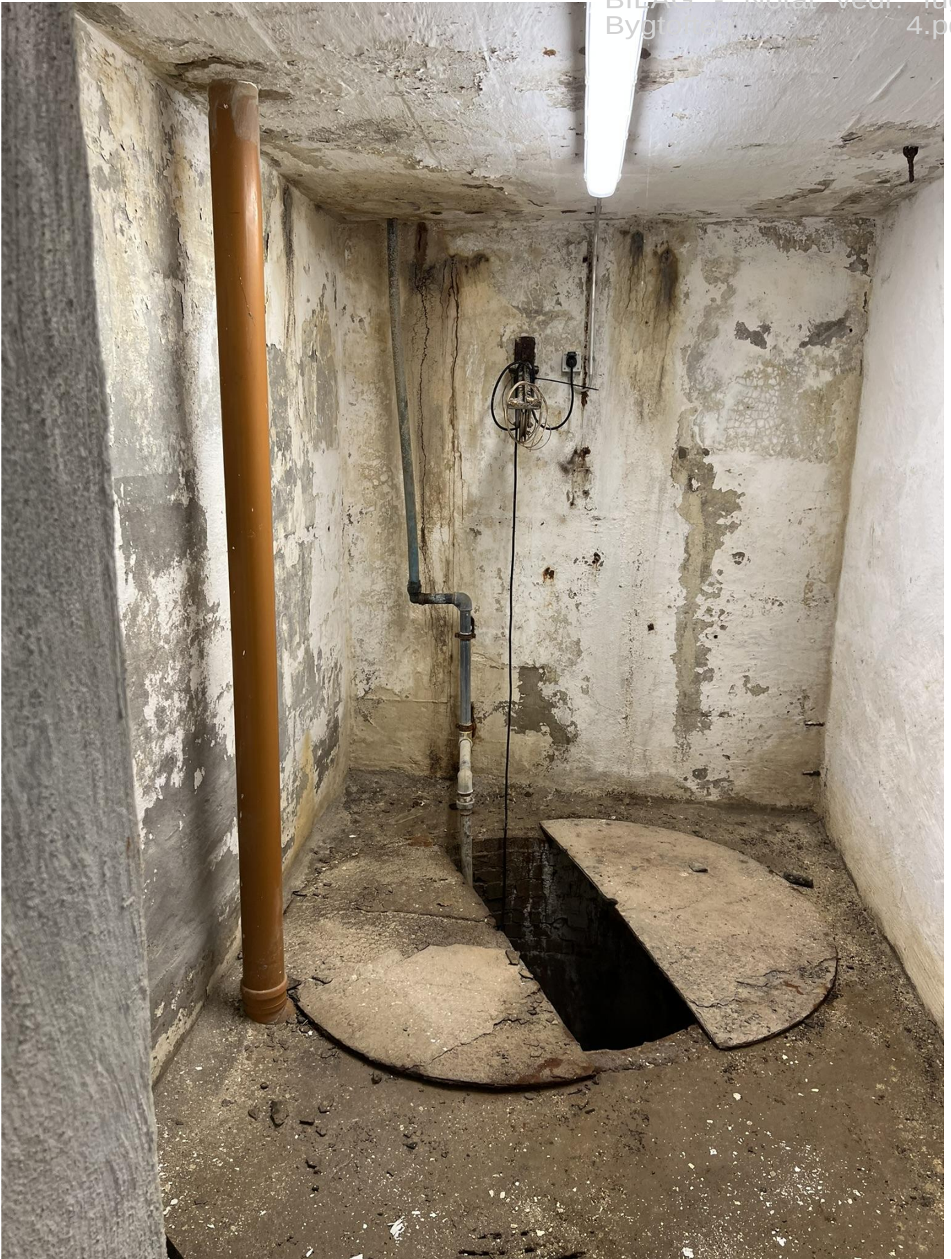
Kælderdel som ligger ud under terræn.
